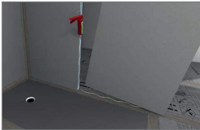
Die wedi Wandelemente vereinen Funktion und Form in perfekter Weise. Zwei Bauplatten mit lediglich 8 cm Stärke reichen aus, um eine freistehende Wand zu errichten – bis 180 cm breit, bis 260 cm hoch und absolut stabil. Verklebt werden die Bauplatten mit wedi 610 Kleb- und Dichtstoff. Anschließend können sie direkt verfliest werden.
