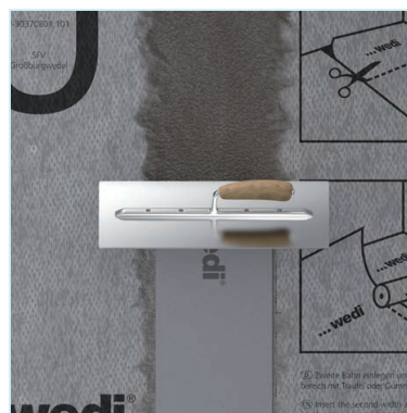
Stoßfugen der wedi Subliner Dry Bahnen mit wedi 520 Flexible Dichtschlämme und wedi Tools Dichtband abdichten.
