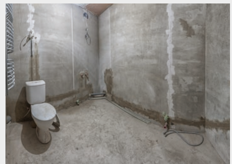
Sanierung im Bestand
