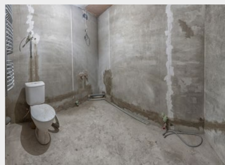
Sanierung im Bestand
