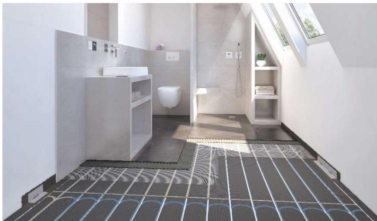
Die Bauplatte wedi PreLine ist das optimale Trägerelement zur Installation eines Heizwassersystems. Der Fachhandwerker muss die Rohre nur in die vorgearbeiteten Aussparungen legen, alles abdichten und armieren und kann dann mit dem Verfliesen der Oberfläche beginnen.
