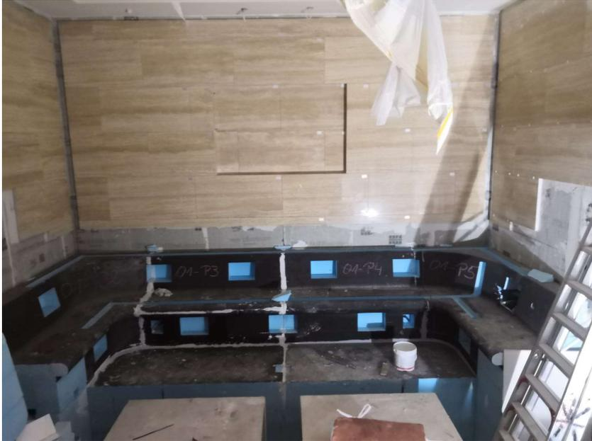
Durch den hohen Vorfertigungsgrad der wedi-Elemente musste die benötigte Technik nur noch in die vorgefrästen Öffnungen eingesetzt werden.
