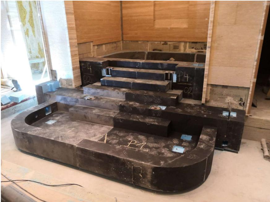
Für den Treppenaufgang zum Pool mussten die wedi Elemente vor Ort nur noch miteinander verbunden, verklebt und vollflächig abgedichtet werden. Danach konnten sie mit den gewünschten Oberflächen verkleidet werden.
