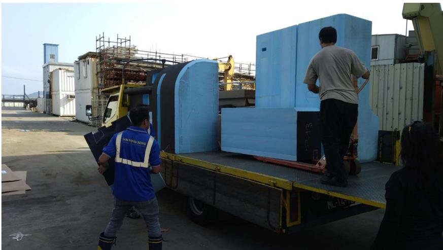
Die einzelnen Bauteile wurden bereits fertig an die Baustelle geliefert. Da sie ein geringes Eigengewicht haben, konnten auch große Teile leicht von nur einer Person transportiert werden.
