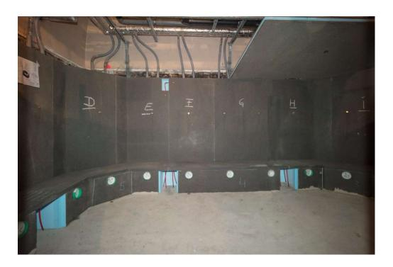
Les murs du laconium et du hammam du Neptunbad sont constitués d'éléments muraux préfabriqués que l'installateur n'a eu qu'à mettre en place et à coller entre eux. Les bancs ont également été préfabriqués en usine. Un montage d'essai chez wedi dans le hall de l'usine a garanti que tous les éléments étaient parfaitement adaptés sur le chantier.
