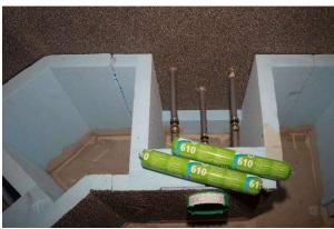
Pour les soubassements des banquettes, les I-Box ainsi que les tuyaux de raccordement ont déjà été installés et étanchéifiés en usine. Avant de pouvoir coller l'assise sur les éléments porteurs avec wedi 610, les conduites ont été pressées par l'installateur.
