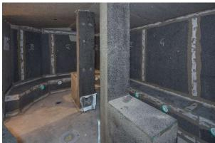
Les deux colonnes vers le plafond pour la sortie de vapeur avec la boîte à vapeur ont été construites sur place par Wolfgang Peters avec des panneaux de construction. Des plaques de fixation spéciales ont été collées dans les colonnes, dans lesquelles l'installateur a pu fixer la conduite de vapeur, la conduite de condensat et les tuyaux d'arrivée d'air pour le caisson de vapeur.
