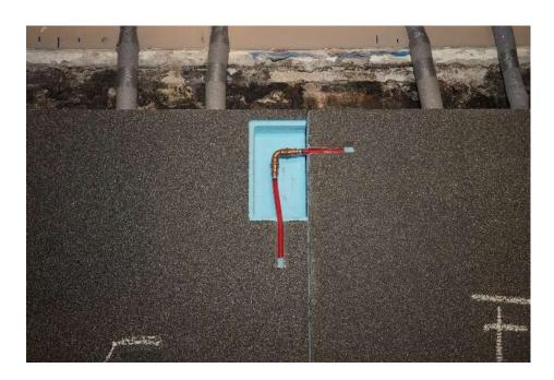
Les étapes de travail dans le bain de Neptune étaient parfaitement coordonnées. Les éléments muraux ont été livrés sur le chantier avec la tuyauterie intégrée en usine. Lors de la mise en place, les murs ont été collés entre eux et les tuyaux ont été serrés par l'installateur.
