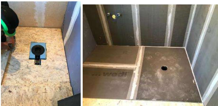
Une base de drainage wedi a été utilisée pour les douches avec le même niveau de plancher. Les artisans y ont mis la douche Fundo Primo. Le sol autour de la douche est recouvert de plaques de construction wedi pour protéger le plancher en bois délicat de l'humidité.
