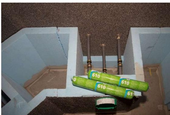
Le scatole e i tubi di collegamento per i supporti del sedile sono già stati installati e sigillati in fabbrica. Prima che la superficie del sedile potesse essere incollata agli elementi di supporto con wedi 610, i tubi sono stati pressati dall'installatore.
