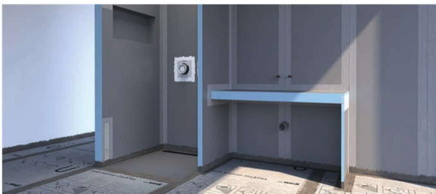
Per ristrutturazioni con altezze di installazione molto basse, vengono utilizzati sistemi speciali, ad esempio gli elementi doccia wedi Fundo con tecnologia di drenaggio integrata.
